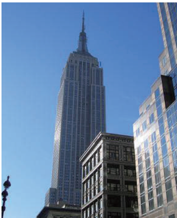
エンパイアステートビル省エネ大改修2012年竣工 5億5千万ドル テナント充実、観光客増加
