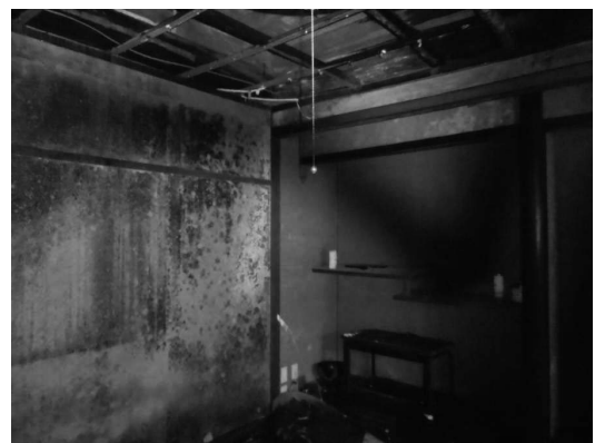
カビなどによる、被害も甚大
