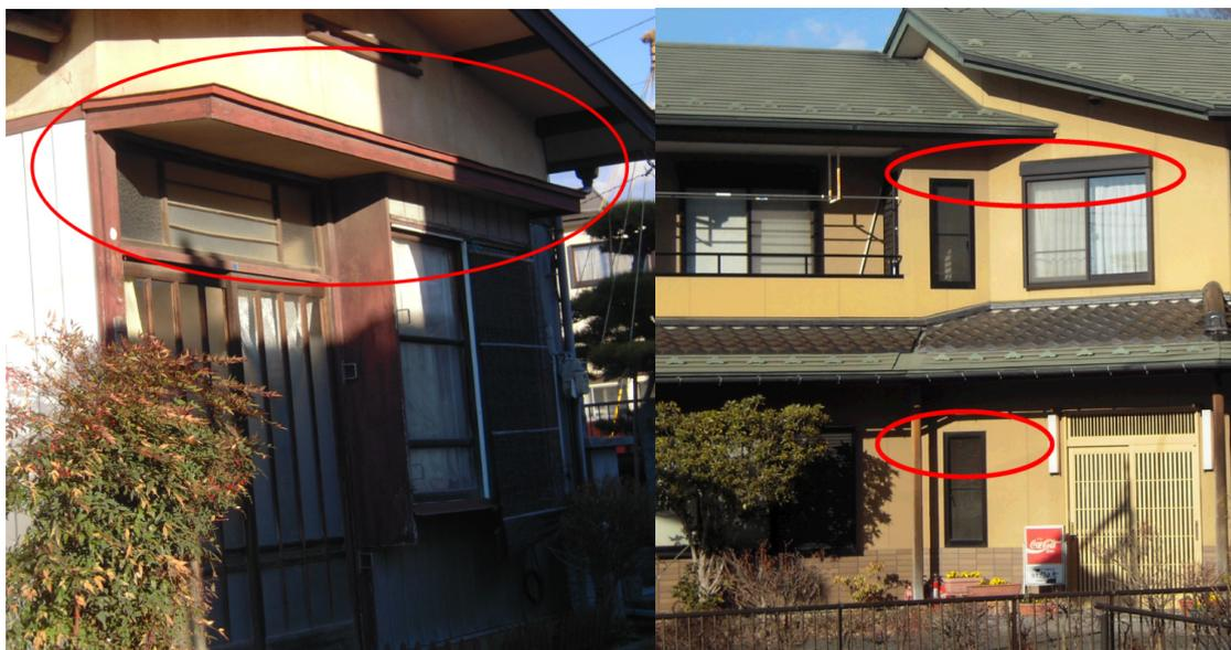
最近では建具の雨仕舞の向上により、右の写真のように建築されない建物が増えている。
