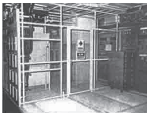
受変電設備（電気室型）
